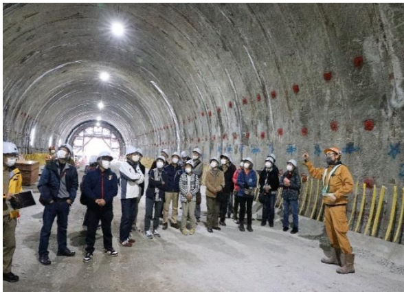
貫通した鳳坂トンネルを見学する参加者
